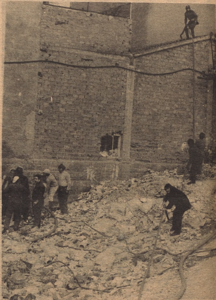
Las bombas extintoras se introducen por los boquetes abiertos en el edificio. Es el único camino para el rescate de las víctimas, y primero hay que limpiarlo de las llamas, que lo derran.
