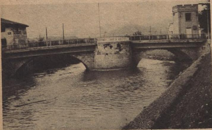
Perspectiva del río Jalón a su paso por el puente de La Merced, después de haber pasado ya las obras de dragado, y consolidación de muros. (Foto: Montañés).
