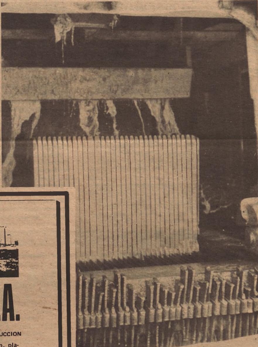
En el taller de marmolería, la máquina corta en losas un gran bloque de mármol procedente de Carrara. Las sierras cortan a una velocidad de un centímetro por hora.
