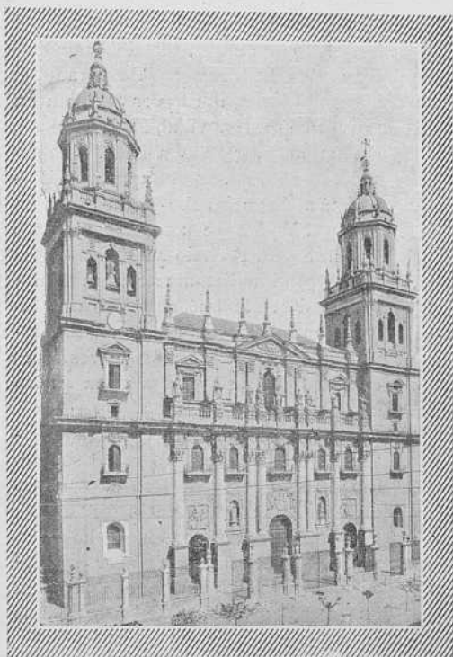
Fachada principal de la Catedral, notable obra de Pedro de Valdevira.
