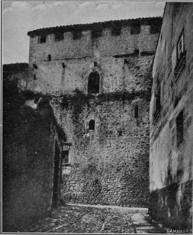
Torre solar de Barreda, siglo XIII, llamada del Merino, fachada del Norte
