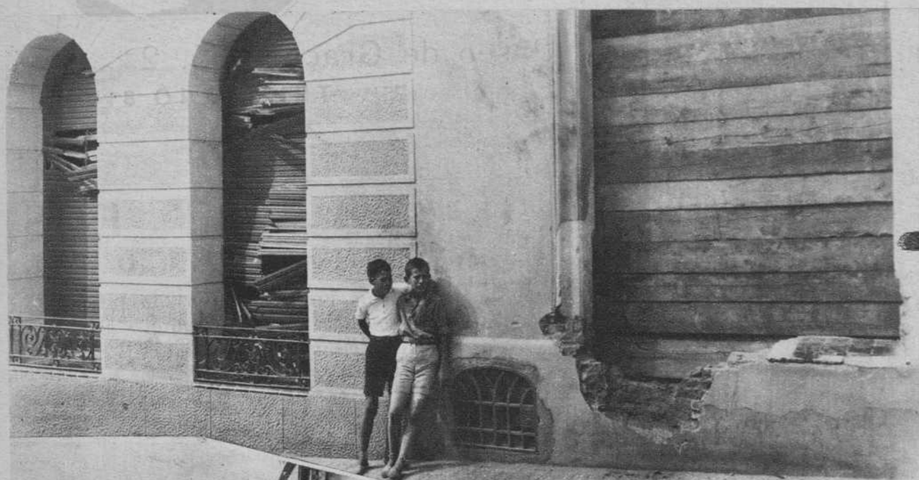
Desperfectos causados por la bomba que estalló en la casa de don Miguel Tossas, en la calle de Berna, 25. — (Fot. Merletti)
