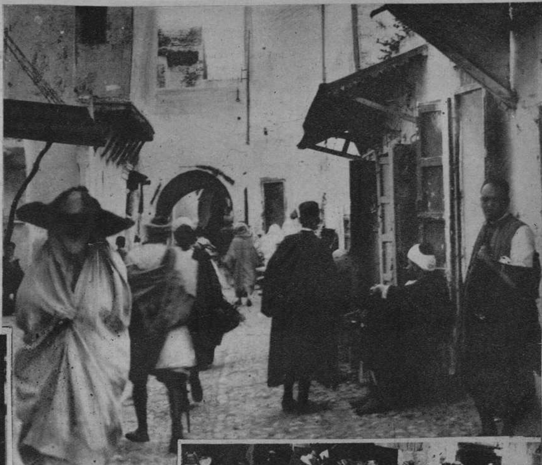
Calle principal del barrio moro
