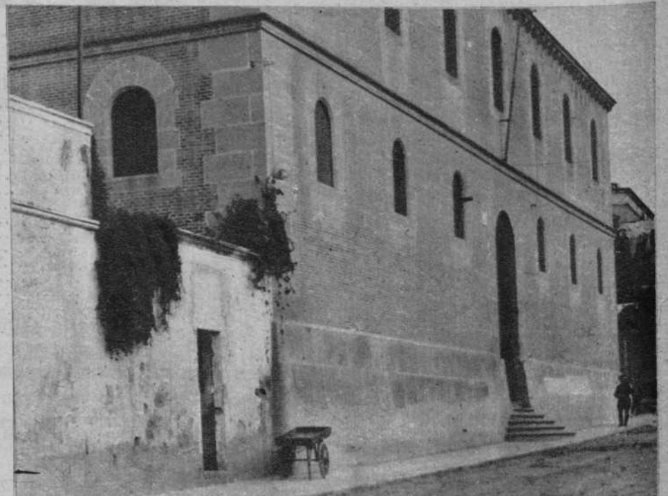
Edificio de la Cárcel nacional de Mataró, en que produjeron los presos un alboroto, prendiendo fuego al edificio. — (Fots. Merletti)
