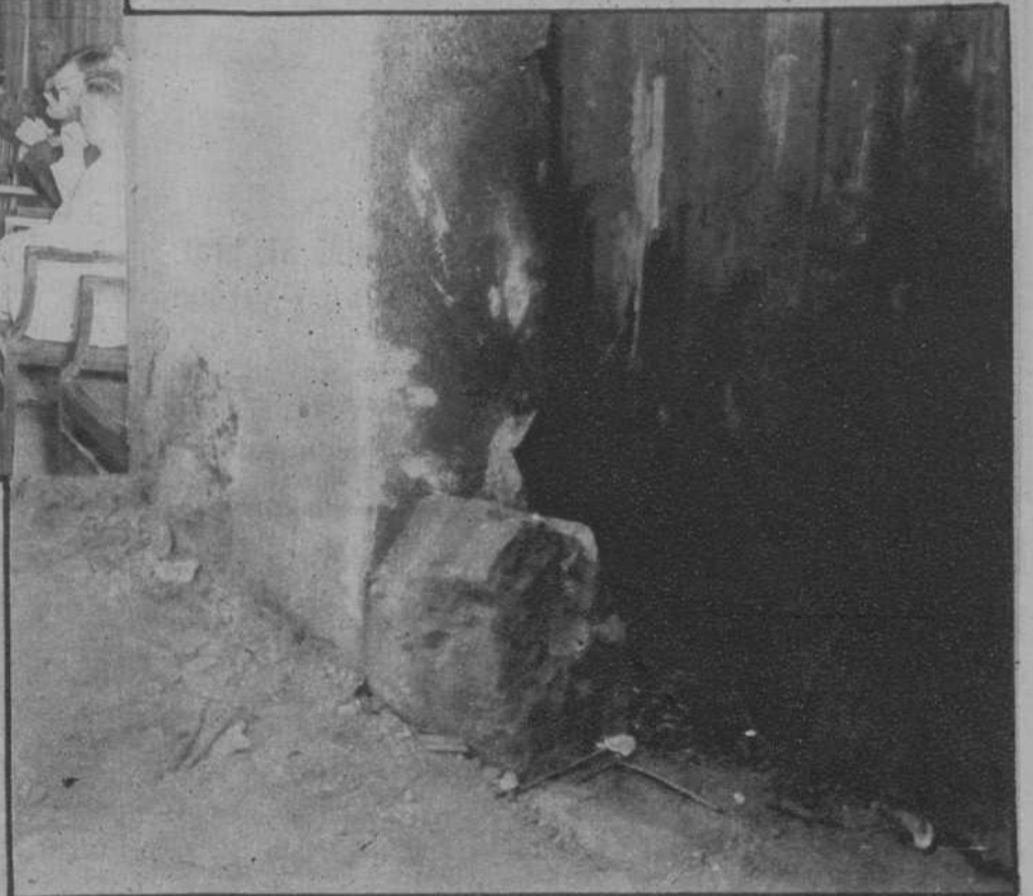
Destrozos causados por la explosión de una bomba de gran potencia, en la casa en construcción de la calle Vila-Vilá, números 32 a 38.—(Foto. Pérez de Rozas)
