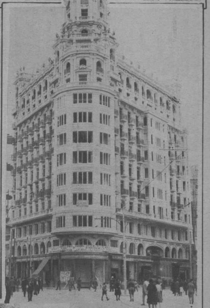
Uno de los nuevos edificios de la calle de San Vicente
