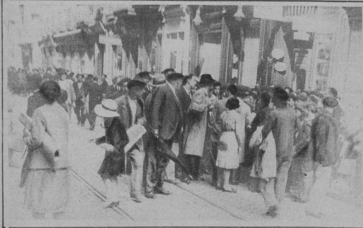
El público, en la calle de Bidebarrieta, contemplando los destrozos causados en la fachada de algunas casas por el tiroteo habido durante los últimos sucesos.—(Fts. Amado)
