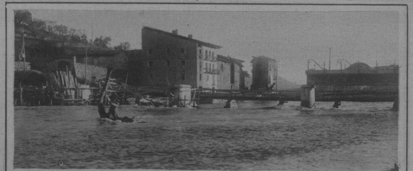
Pont de Claverol.—Las últimas crecidas del Noguera Pallaresa, han puesto nuevamente en peligro la pasarela provisional que une los distritos de Claverol, Ortoneda y Aramunt con Pobla de Segur, mientras se termina la construcción del puente definitivo, cuyas obras ha habido que suspender ante la furia de las aguas.—(Fot. Gordó)
