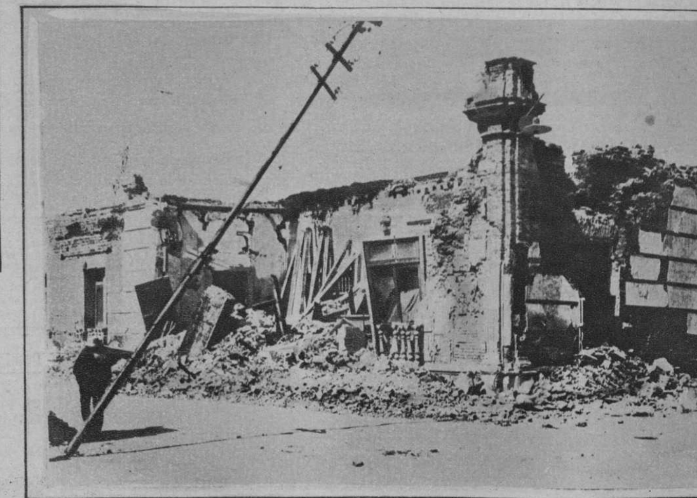
Un terremoto en Oaxaca (Méjico) ha destruido gran número de casas.—(Fot. Keystone)
