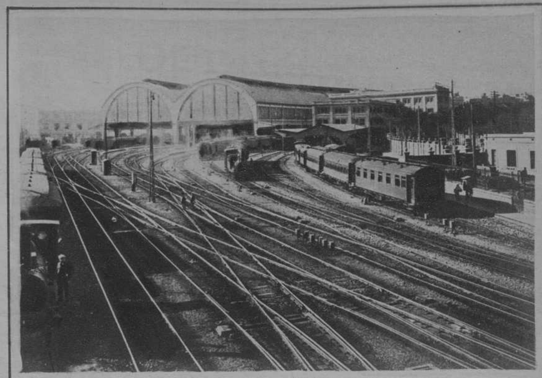
Un detalle de la entrada de la Estación Barcelona-Término, vista desde el puesto de maniobras
