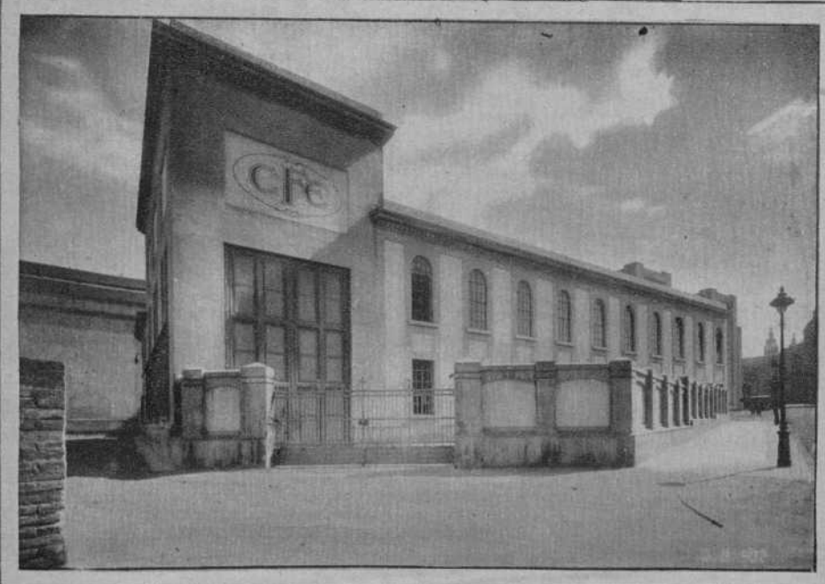
Estación transformadora construida por COOPERATIVA DE FLUIDO ELECTRICO, S. A., en la calle de Méjico, para el suministro de energía a la Exposición
