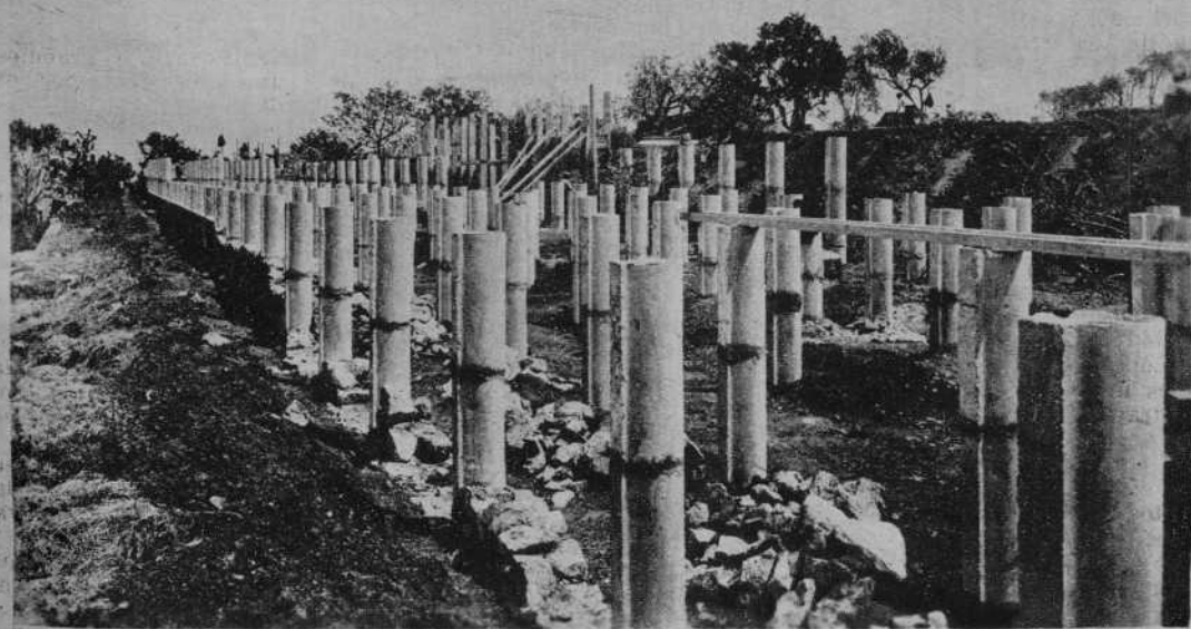
Cimentación de las grandes montañas rusas que constituirán una de las más sugestivas atracciones
