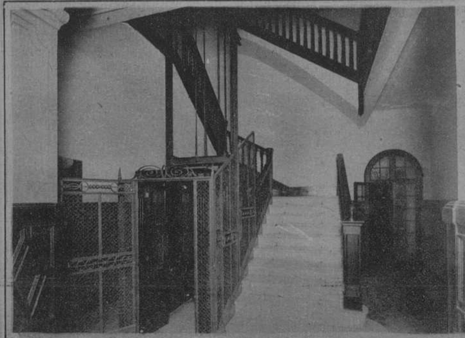
Escalera y ascensor para acceso a las habitaciones altas
