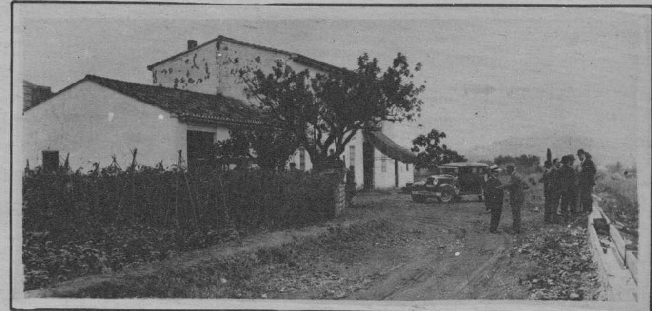
MASIA DE CASANOVA. — Canal de distribución de riego para las 250 hanegadas transformadas de secano en regadio en dicha Masia
