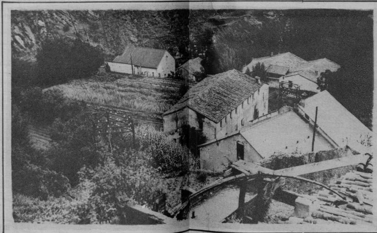
CENTRAL HIDROELECTRICA DE ANNA. DE LA UNION ELECTRICA LEVANTINA
