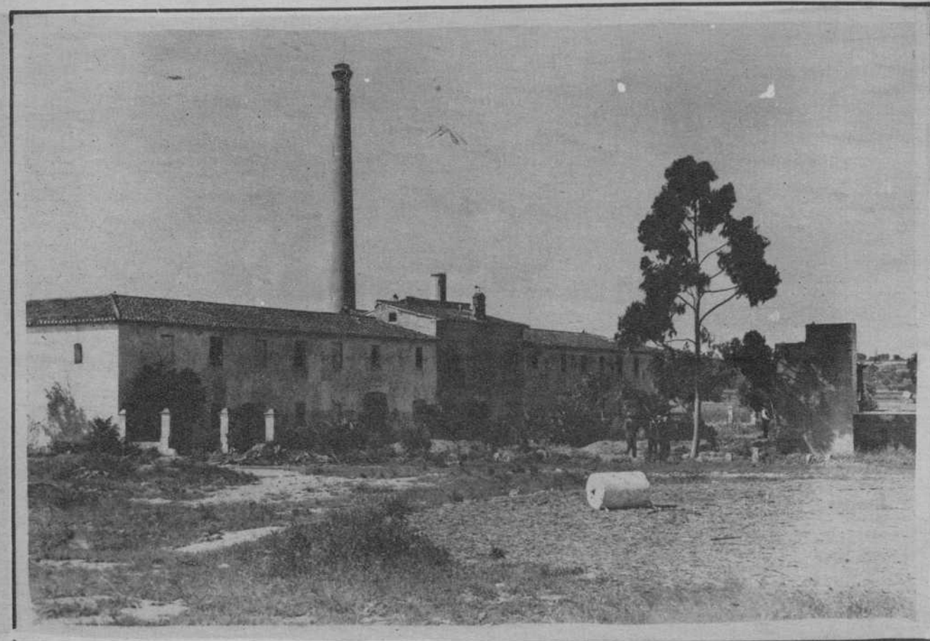
Edificio de la Masia de San Antonio, de 2.500 hanegadas en condiciones de riego y con un pozo de 10.000 litros por minuto y capaz de alcanzar hasta 20.000 litros
