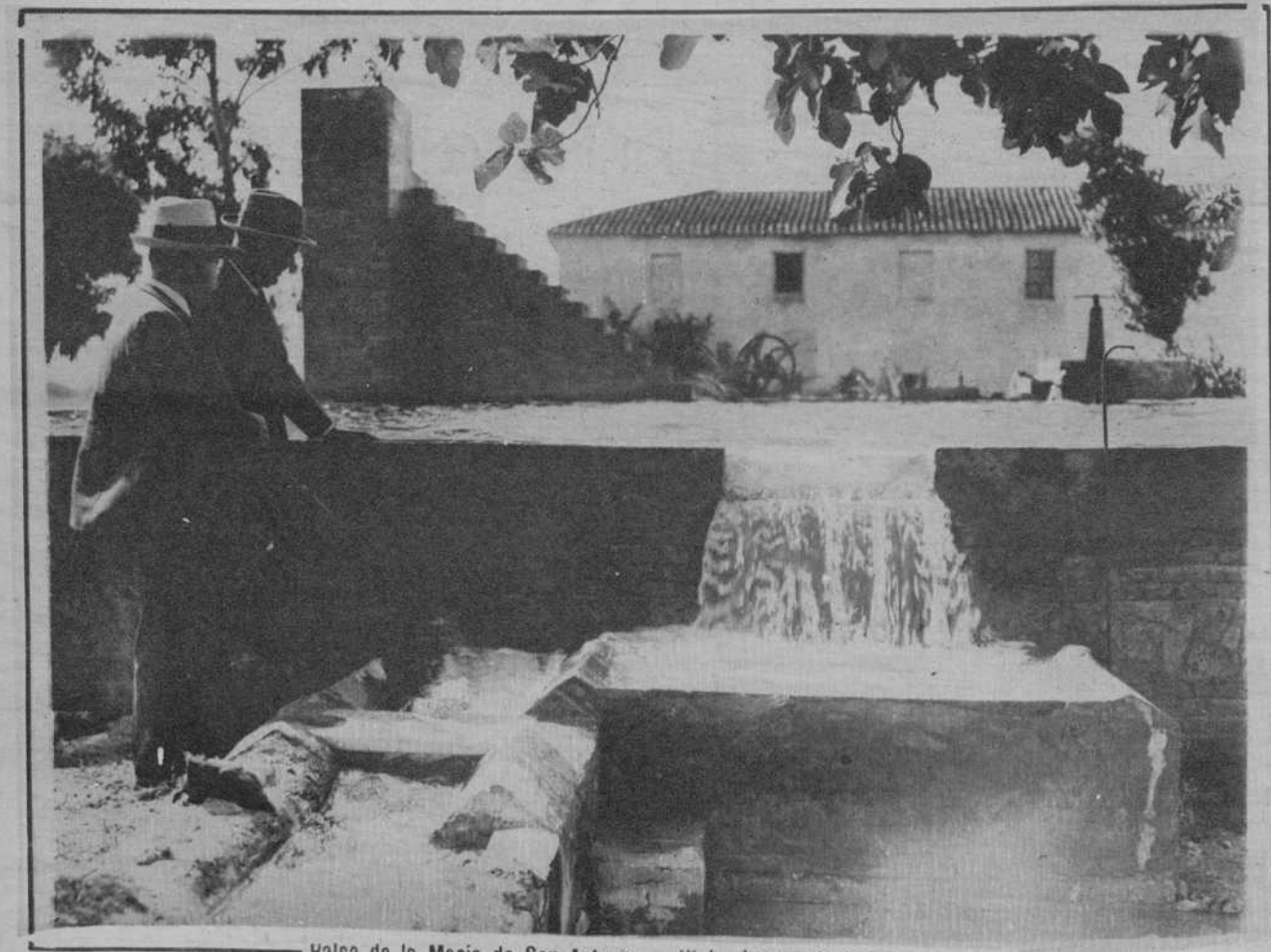
Balsa de la Masia de San Antonio. — Vista de una de las salidas de distribución de agua del magnífico pozo que da 10.000 litros por minuto y que podrá llegar a los 20.000 litros por minuto
