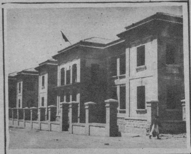
ESCUELA EN CONSTRUCCIÓN EN LIRIA (VALENCIA)
