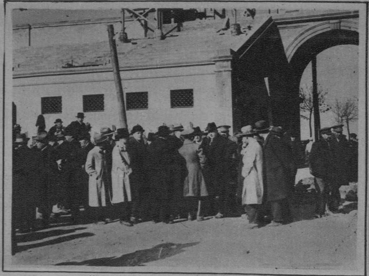
Visitando las obras del Estadio.—(Fot. Badosa)
