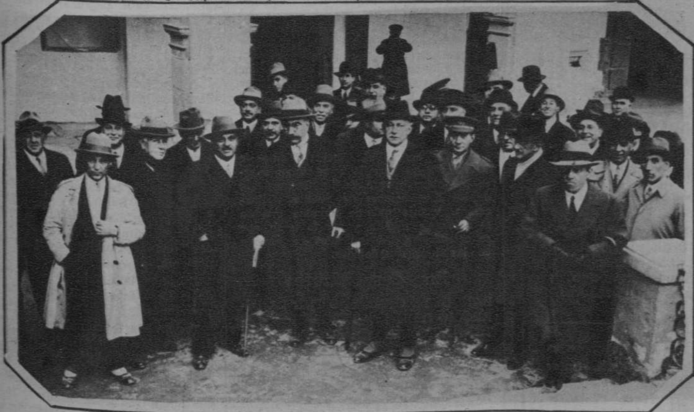
En las obras del Pabellón del Pueblo Español.—(Fot. Merletti)
