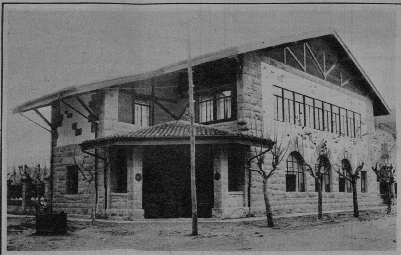
Tiene esta nueva subcentral de Las Arenas, de Bilbao, el encanto y el buen gusto del estilo sobrio y cordial de las construcciones esencialmente vascas
