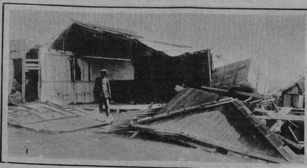
Estado en que quedó una construcción
