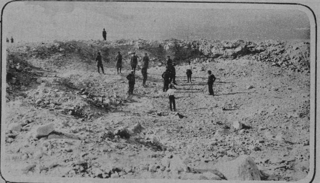
El emplazamiento del fuerte, después de la explosión. Enorme embudo de más de 30 ms. de diámetro, por 5 de profundidad
