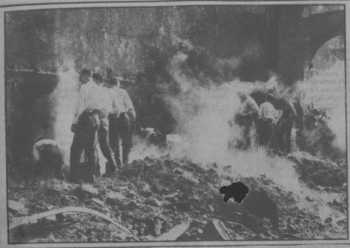
Los bomberos, durante la extinción del incendio, buscando cadáveres entre los escombros.
