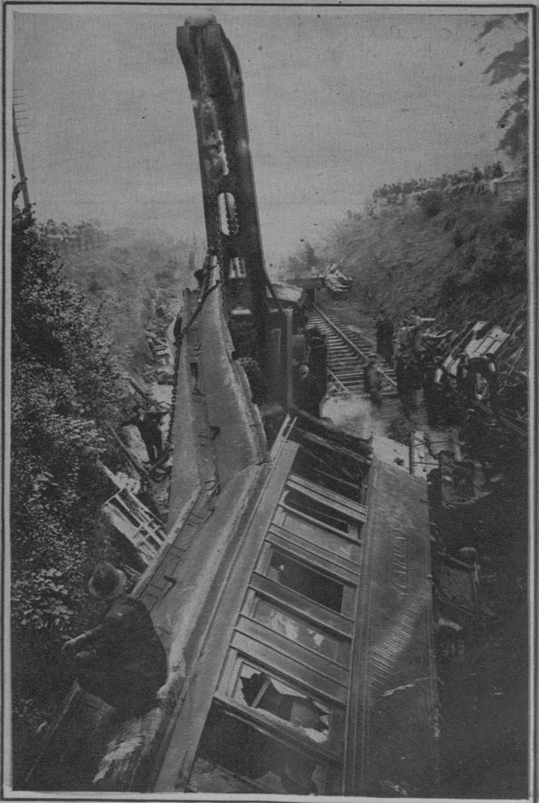
LONDRES.—Forma en que quedaron los vagones del expés que descarriló entre Londres y Dover, causando numerosas víctimas. Una potente grúa trabaja para despejar la vía. (Fot. Keystone).
