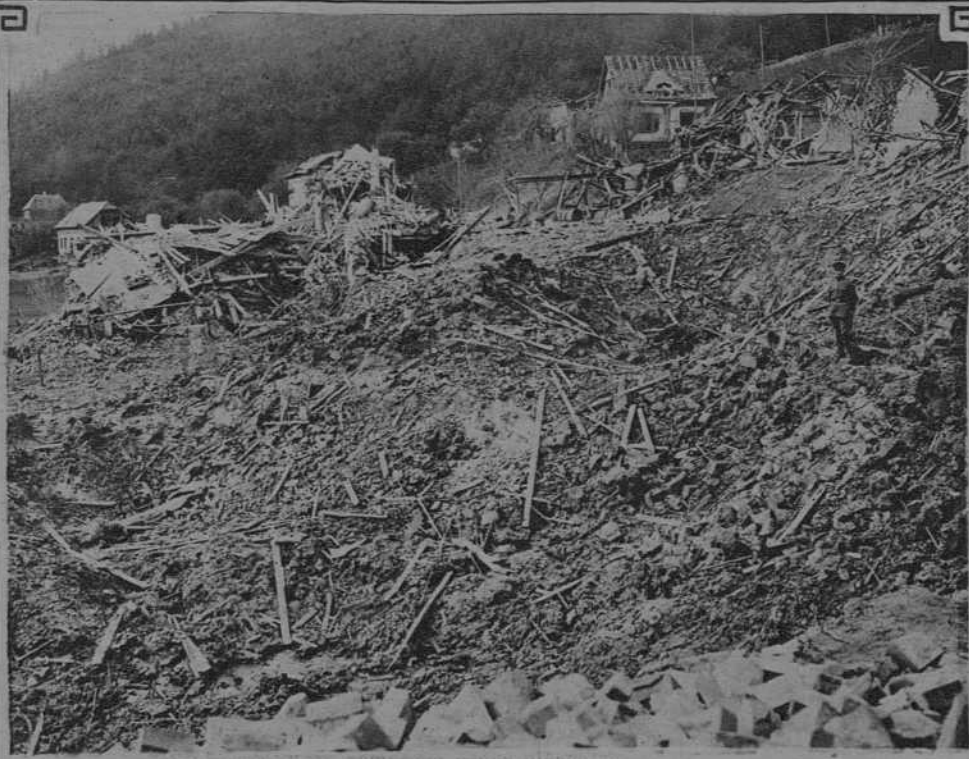
Hasloch (Alemania). - Una terrible explosión hizo volar la fábrica de pólvora instalada en dicha localidad. - Lo que quedó del edificio después de la catástrofe. (f. Dida)
