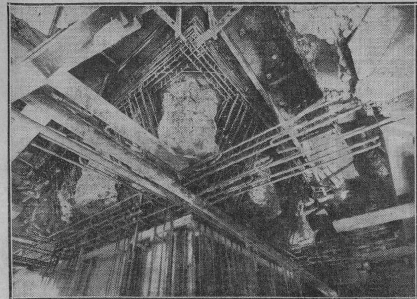
Fotografía obtenida de los trabajos de cimentación de una de las pilastras que sostiene el templo (Fots. Mora)
