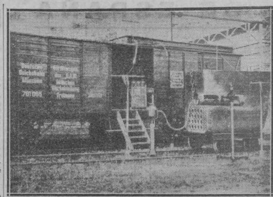
Una potente instalación de rayos X (R. A. W. München-Freimann) instalada en un vagón de ferrocarril, con objeto de investigar radiográficamente los defectos de las locomotoras sin desmontarlas
