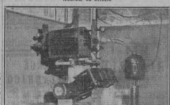
En pleno examen de una locomotora por medio de los rayos Roentgen. El aparato está inclinado. A la derecha, la bomba para refrigeración. Se examina el estado de los tubos de la caldera
