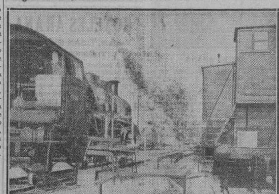
La instalación de rayos X examinando una locomotora para localizar su defecto
