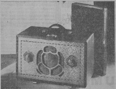
El nuevo modelo 413, receptor de viaje, para corriente alterna y continua, de seis válvulas, circuito superheterodino, con dispositivos hasta ahora no empleados, que presenta la casa Majestic
