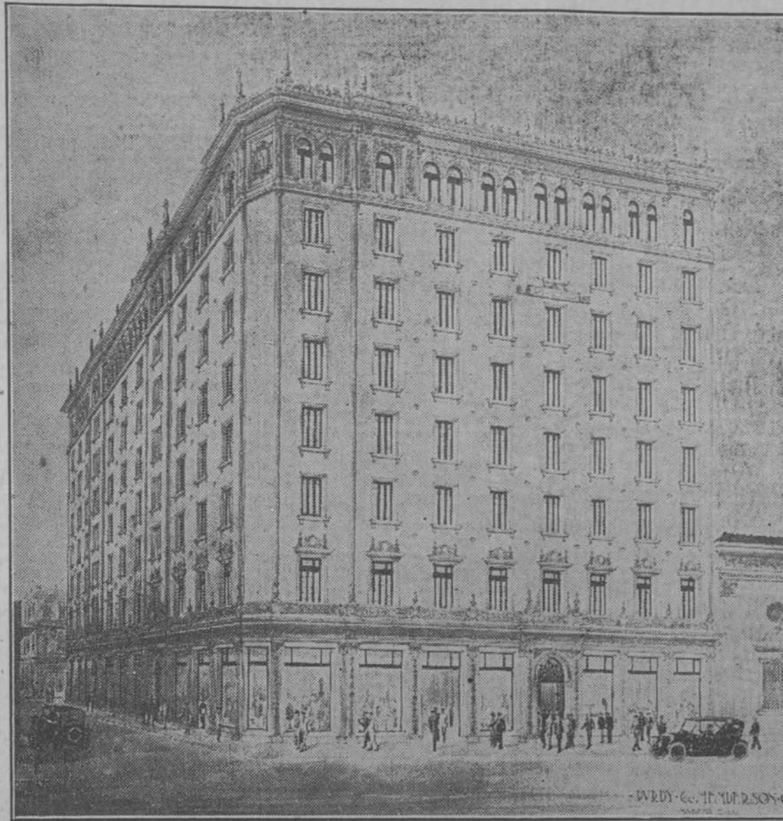
Edificio en construcción en las calles O'Reilly, Aguacate y Progreso. Proyectado por los señores Purdy & Henderson y en construcción por los mismos
