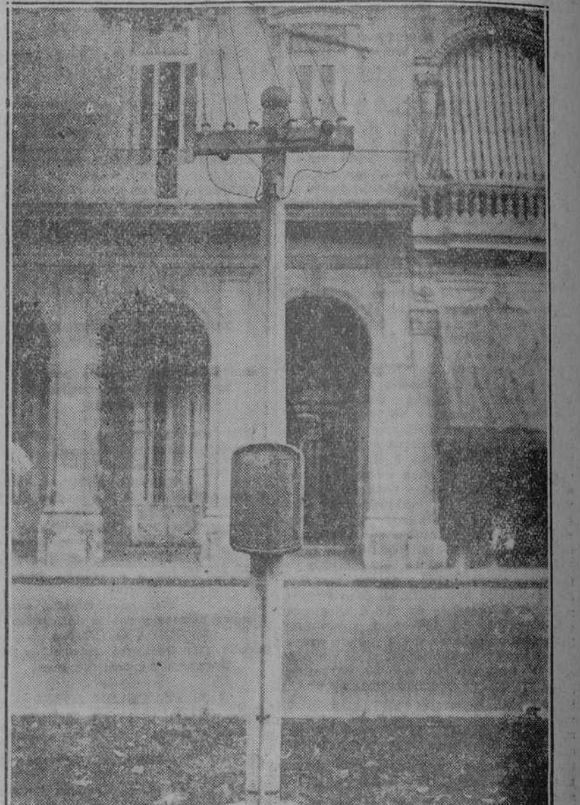
II—Caja de señales instalada en la calle del Prado y cuyo funcionamiento es fácil observar a los habaneros.
