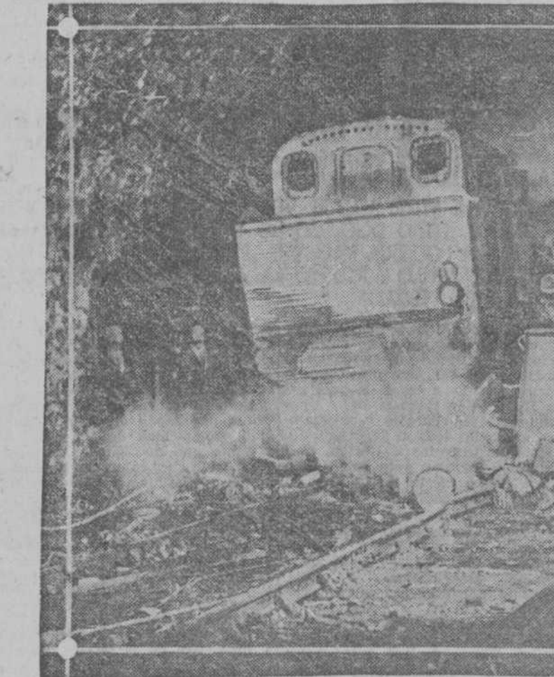
Esta fotografía fué tomada poco después de la colisión, pudiendo verse el estado en que quedó la locomotora. Veinte y seis muertos y más de cien heridos, fué el resultado del choque en el Tunnel Batignolles. Cargados de personas que se dirigían a los teatros, la catástrofe se debió a las luces mal puestas, que ocasionó el choque entre los dos trenes que venían en dirección contraria.
