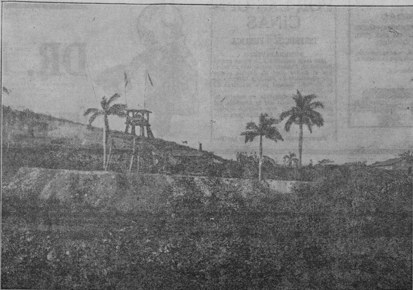
El pozo central, de cuarenta y tres metros de profundidad.
