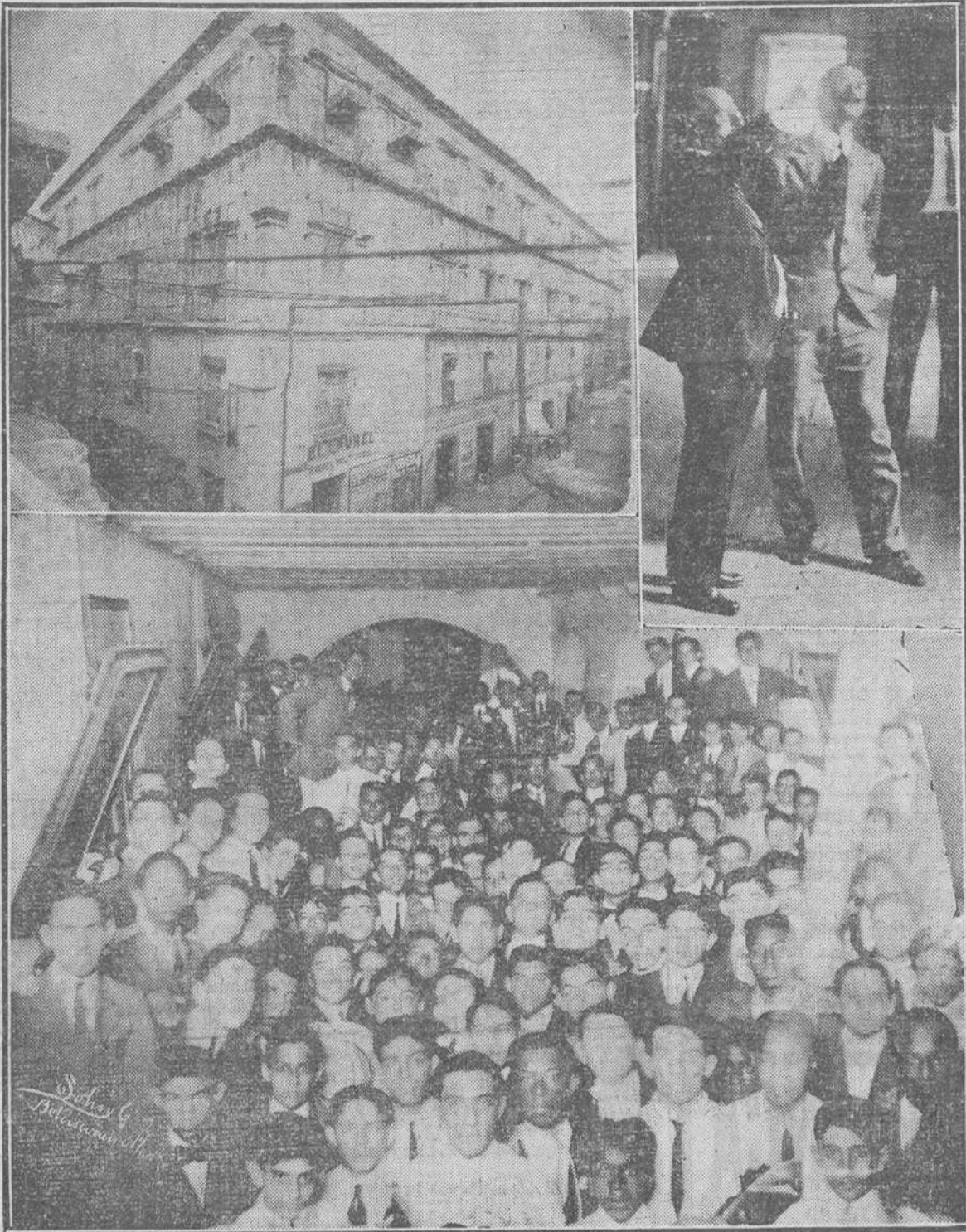
1.—EXTERIOR DEL INSTITUTO, DESDE OBISPO Y SAN IGNACIO.—2.—EL DIRECTOR, DR. PLA, MOSTRANDO UN TECHO RUINOSO A NUESTRO COMPAÑERO SR. OLIVEROS.—3.—ALUMNOS EN UNO DE LOS PASILLOS, AL SALIR DE CLASES.
