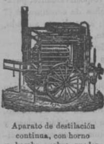
Aparato de destilación continua, con horno y bomba, sobre ruedas.
