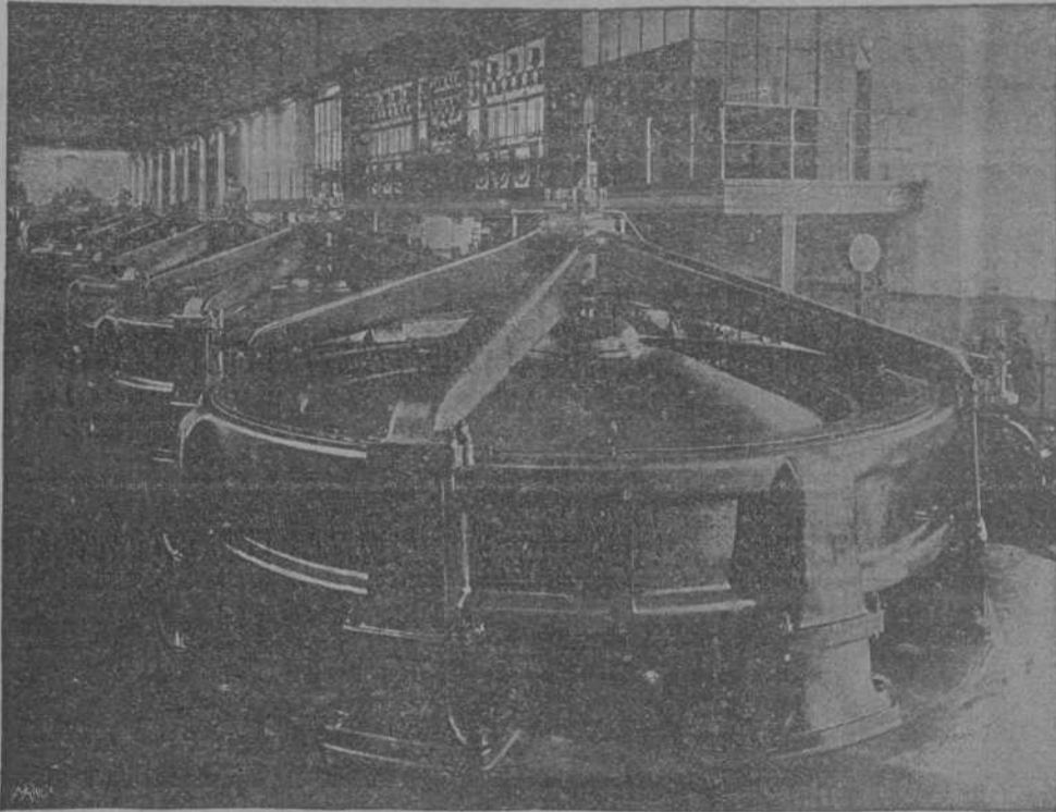
ESTACIÓN CENTRAL RHEINFELDEN Dinamos alterna trifásica movida por turbinas. 600 kw. 630 voltios
