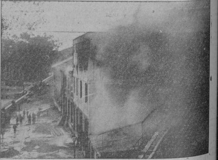
DEL INCENDIO EN LA RAMPA DE SOTILEZA.—La parte principal de las oficinas de Corcho Hijos cuando el fuego estaba en todo su apogeo. (Foto SAMOT).
