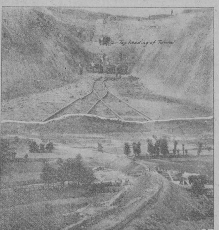
EN LA PARTE SUPERIOR: BOCA DE SALIDA DEL TUNEL DE CARDENADUJO; POR LA PARTE DE MODUBAR DE LA EMPAREDADA, Y EN LA CUAL EXISTE YA UNA PROFUNDIDAD DE OCHENTA METROS.—EN LA PARTE INFERIOR: DESARROLLO DE LA VIA EN EL KILOMETRO 9 DE LA LINEA DE BURGOS A SORIA.
