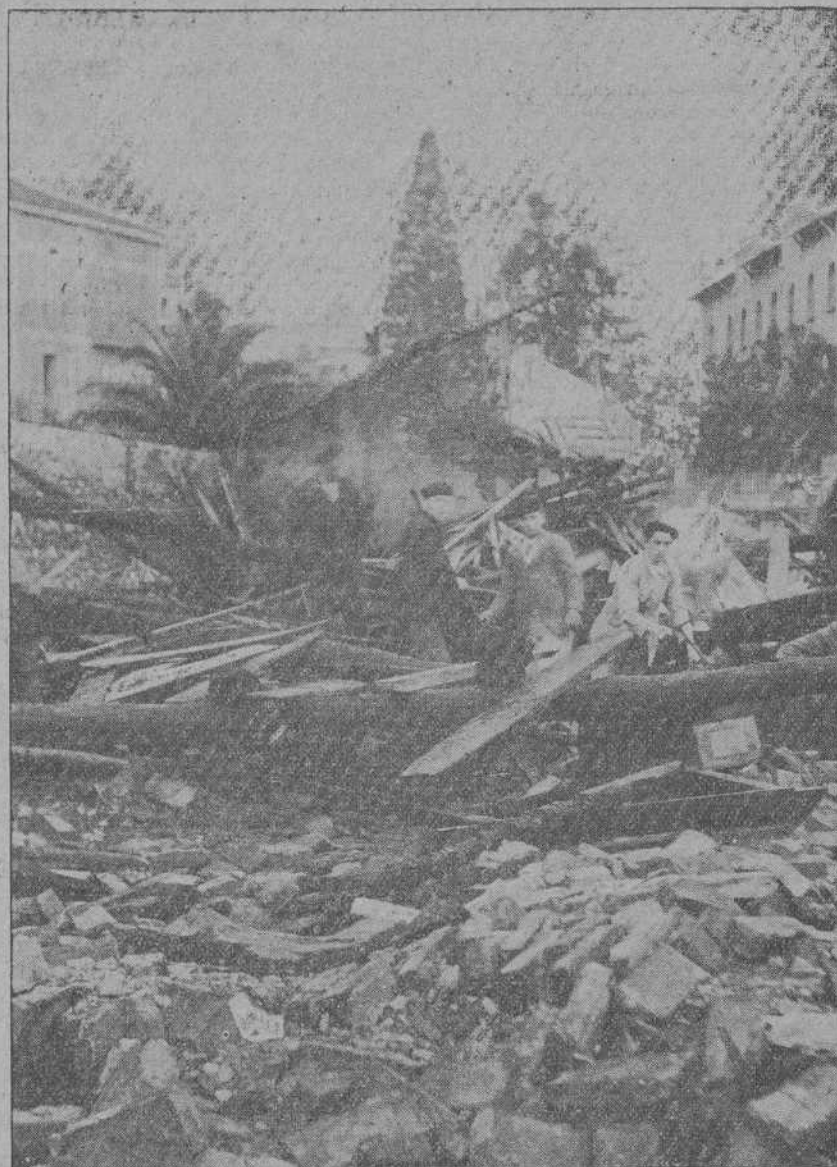
EL INCENDIO DE TORRELAVEGA.—Estado en que quedó el taller de carpintería de los Hijos de Segundo Fernández, después del violento incendio del sábado. (Foto Montesiños.)
