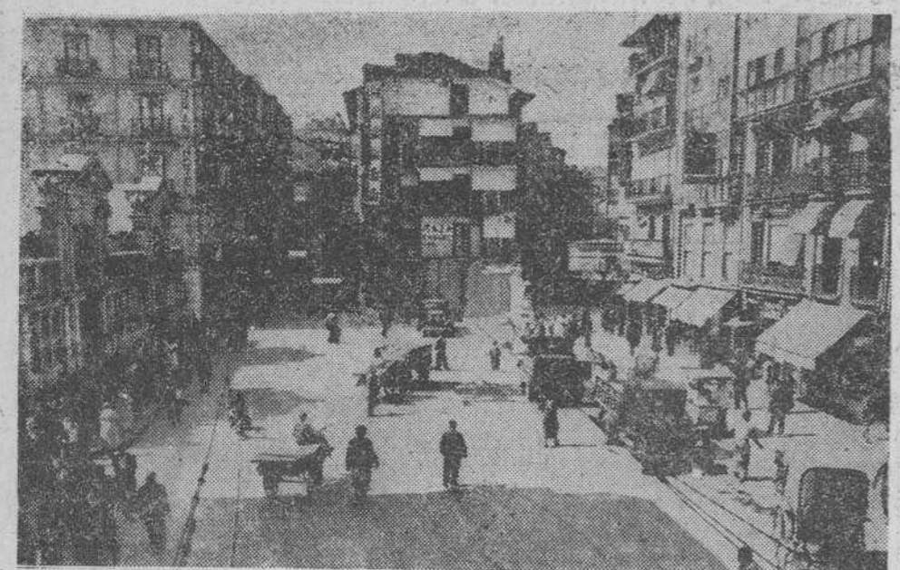
Ya esta "foto" pertenece a la Historia. Así estaba la calle de Atarazanas a finales del año 1886, cuando el alcalde Castillo se dedicaba a derribar manzanas enteras de casas. Lo que él no demolió quedó destruido por el incendio de febrero de 1941.
