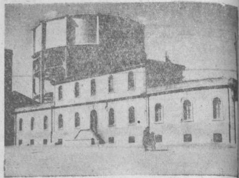
El antiguo depósito de agua de la Prosperidad, con capacidad de sólo para 8.000 metros cúbicos, que con el construido en el Teso de la Chinchibarra —pendiente ahora de ampliación— completará la red de abastecimiento a la ciudad.
