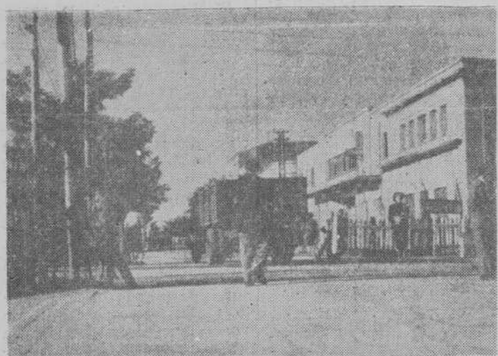
La intensidad de tráfico por la hoy calle de María Auxiliadora y Avenida de Federico Anaya, no pudo ser prevista al pensarse en la desviación del ramal ferroviario
