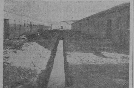
Las zanjas abiertas en las calles del barrio de la Virgen de la Vega, esperan los tubos del alcantarillado, ya colocados en gran parte
