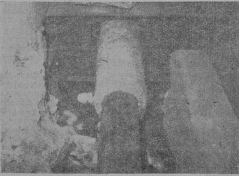
En la entrada del Puente Nuevo, comienza el revestimiento de los tubos con aislante vidriado, para evitar la influencia del frío al pasar bajo las aceras del viaducto
