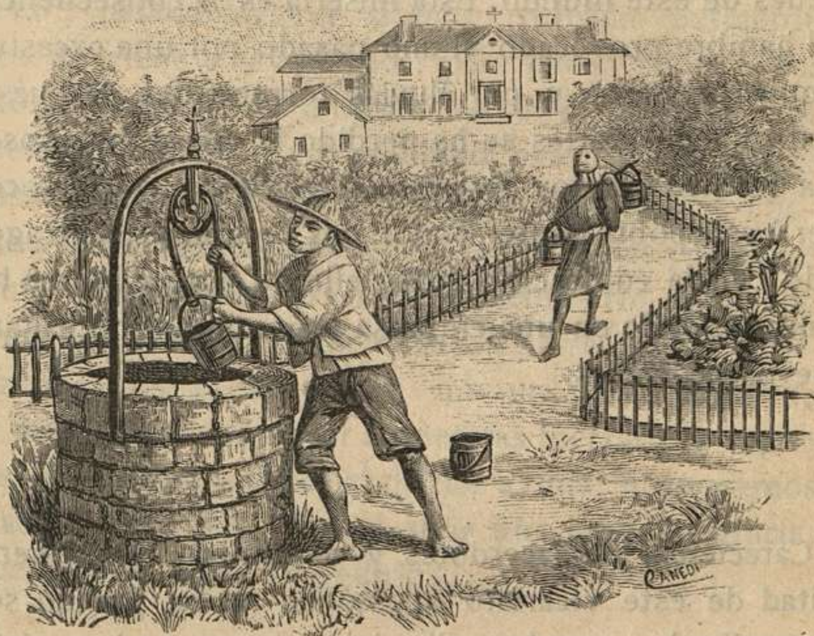
Se abrió un pozo.
