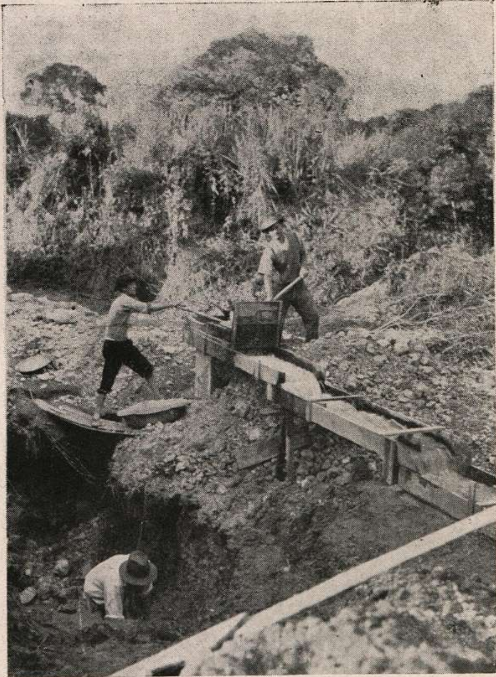
Lavagem do cascalho aurífero em "sluices" no ribeirão dos Cristais.
