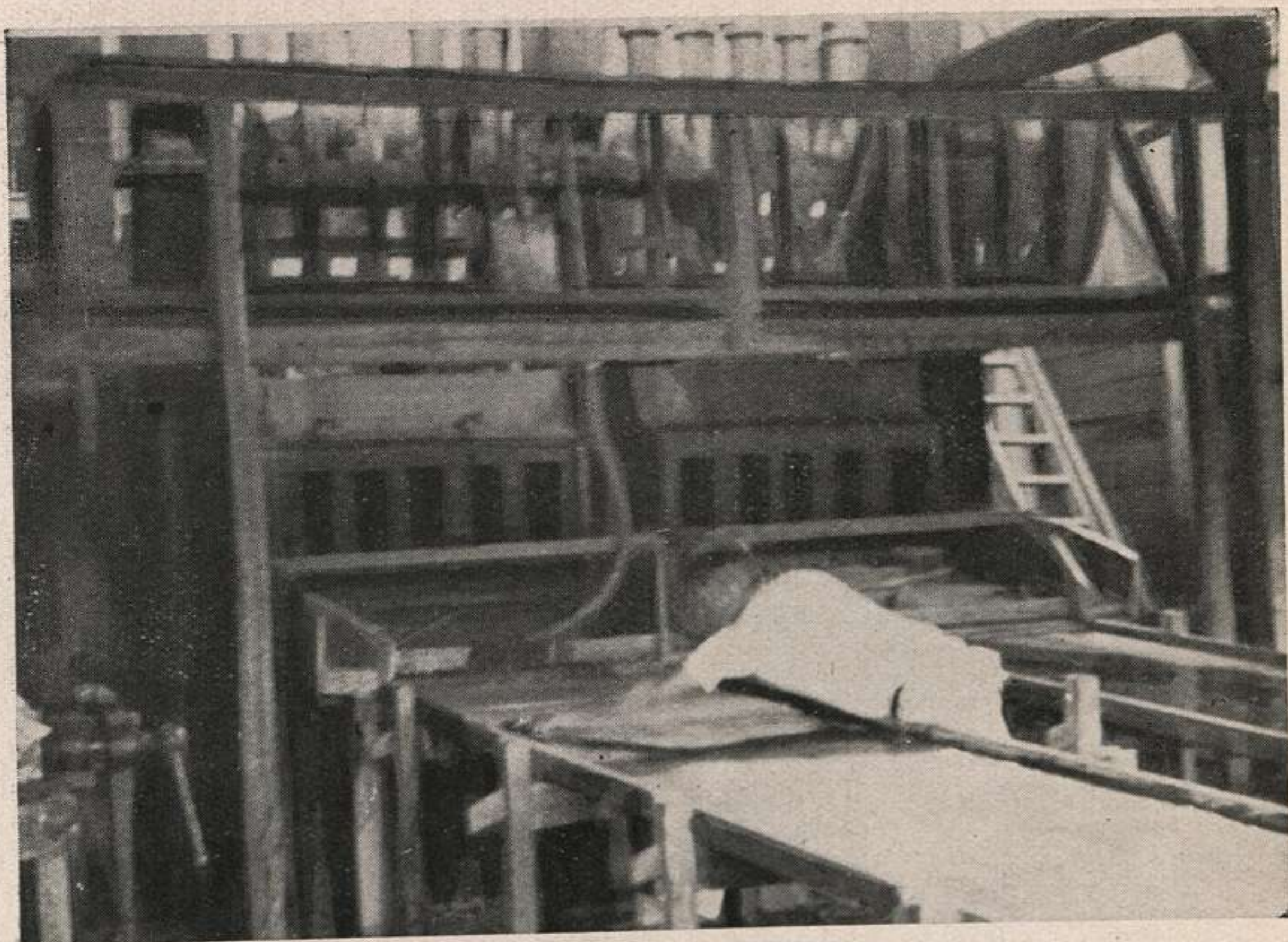
Instalação de amalgamação e trituração do minério aurífero por meio de pilões no sítio Congonhal, Mun. de Itapeçerica.
