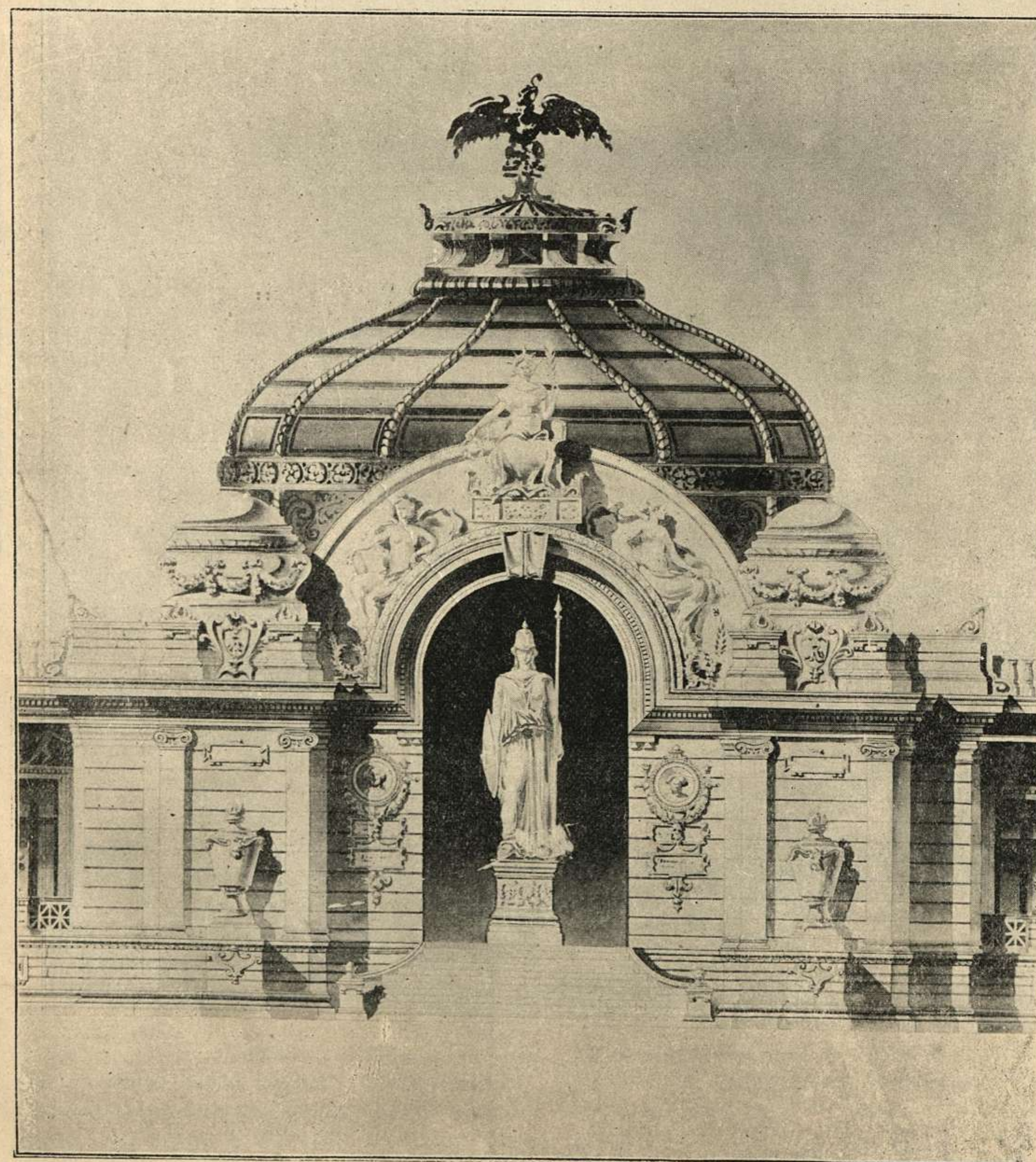
DETALLE DE LA FACHADA.—CENTRO Y PUERTA PRINCIPAL
