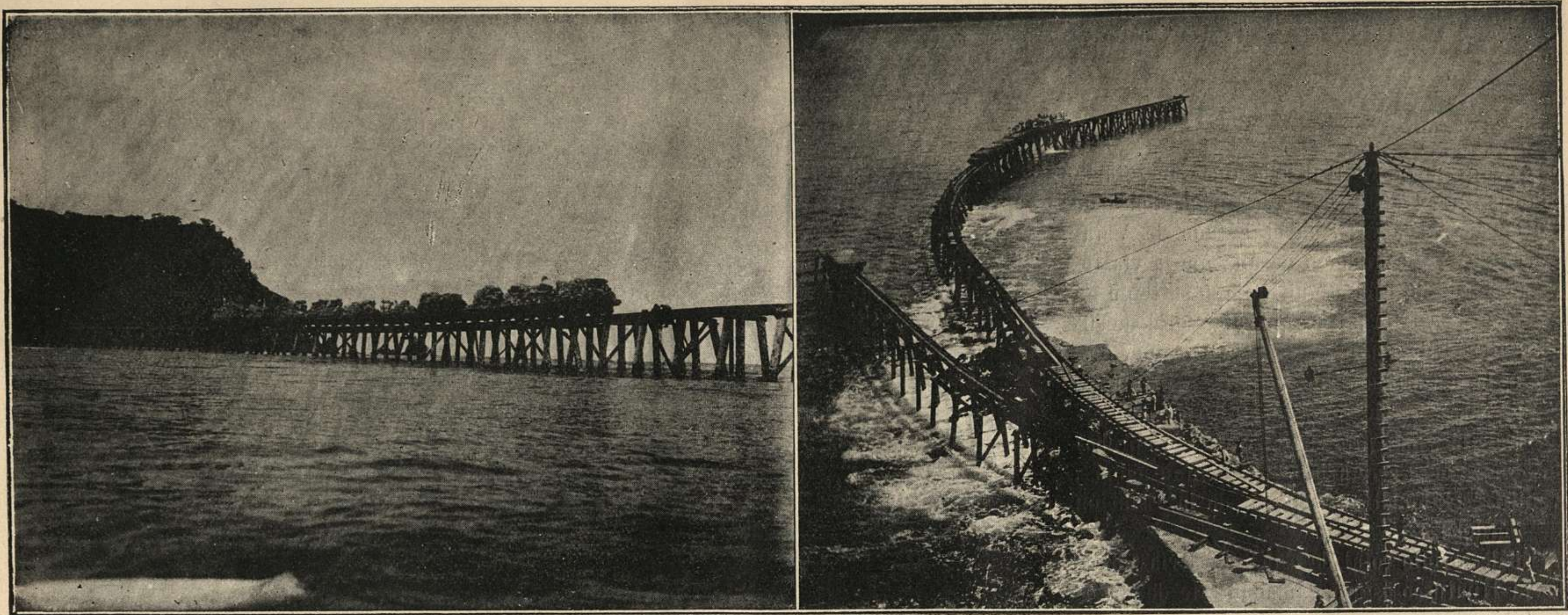
Trabajos de construcción del rompe-olas.
