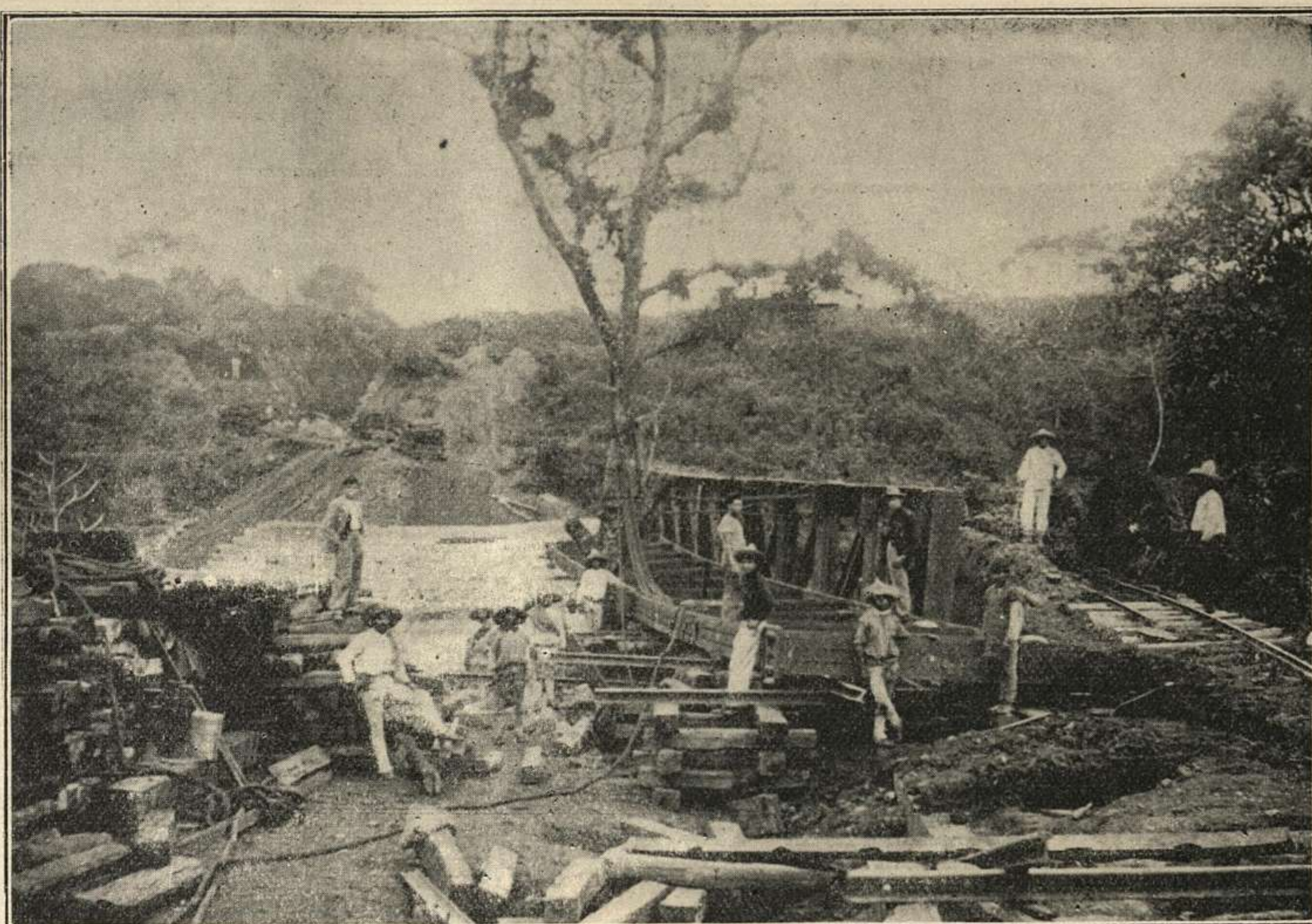
Preliminares para instalar el puente sobre el rio de San Antonio.
