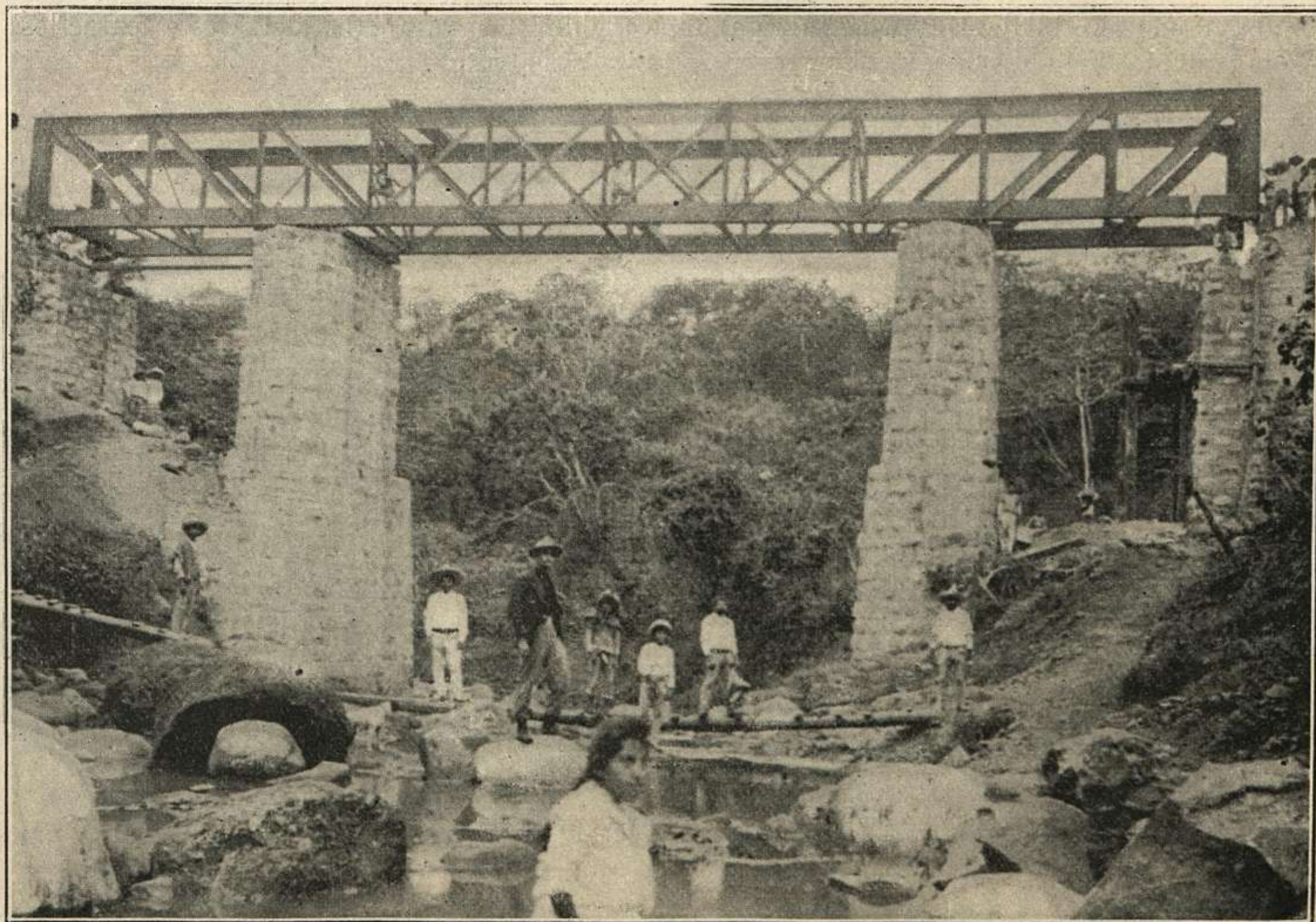
Perspectiva del puente terminado.
