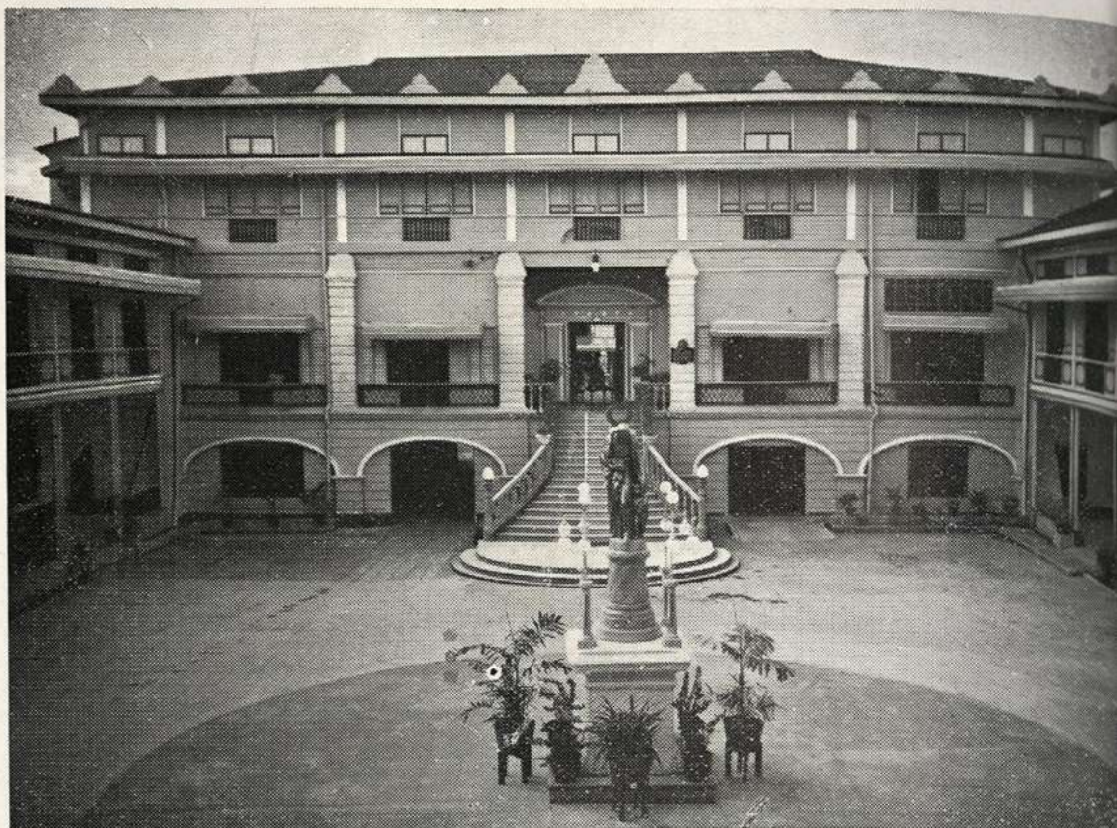
Vista del patio principal.
