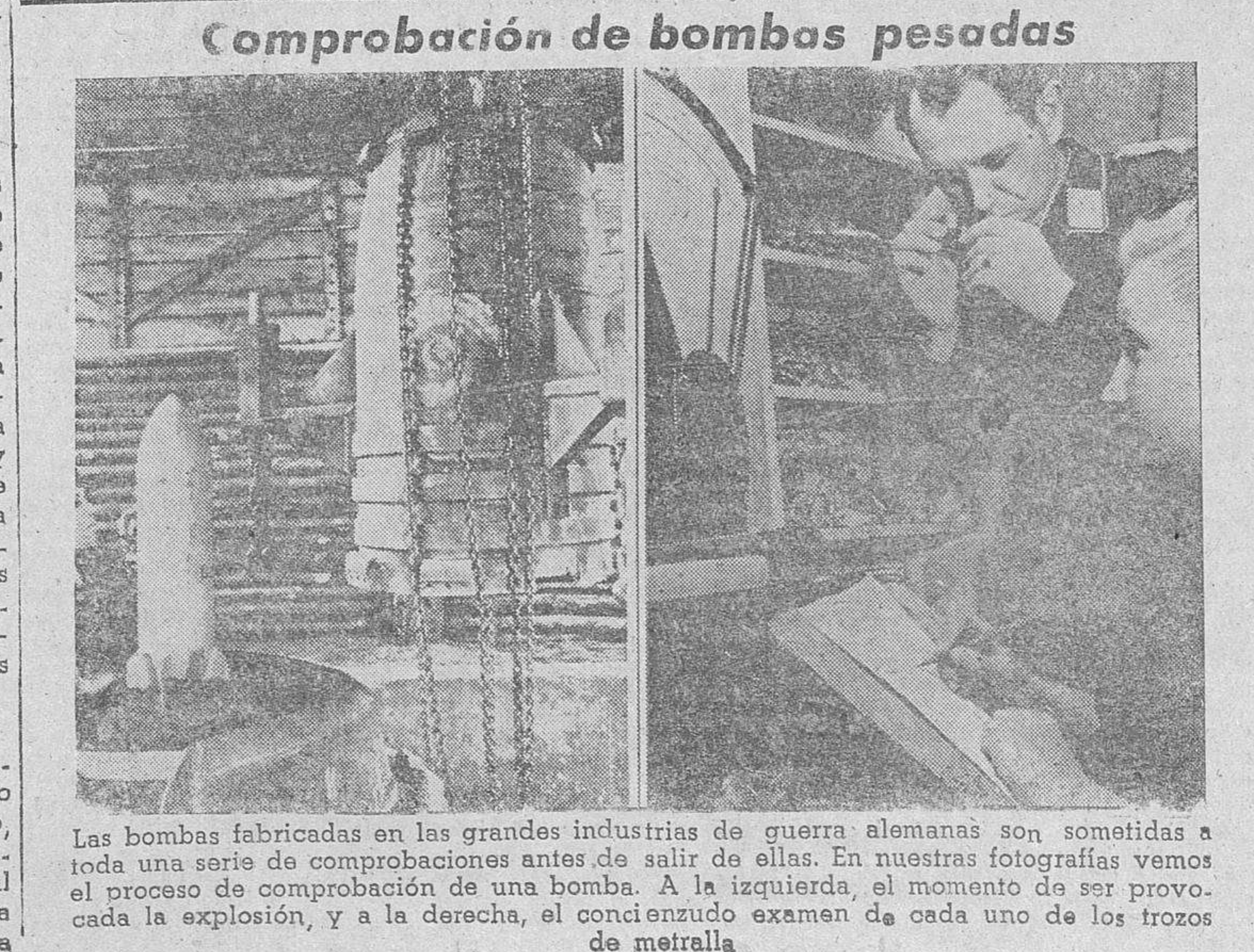
Las bombas fabricadas en las grandes industrias de guerra alemanas son sometidas a toda una serie de comprobaciones antes de salir de ellas. En nuestras fotografías vemos el proceso de comprobación de una bomba. A la izquierda, el momento de ser provocada la explosión, y a la derecha, el concienzudo examen de cada uno de los trozos de metralla
