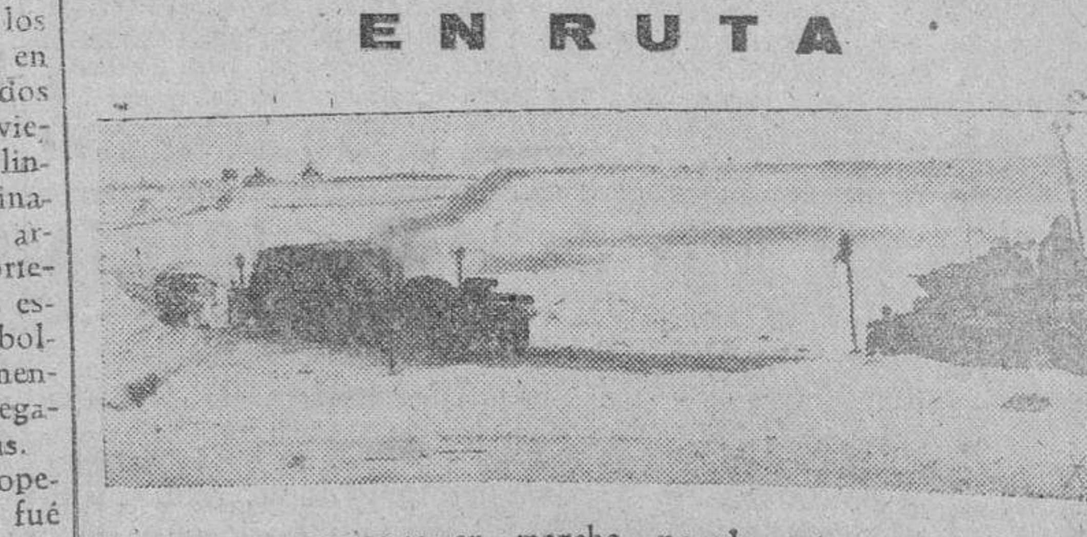
Tanques y camiones en marcha, por la estepa rusa, hacia las líneas avanzadas.
