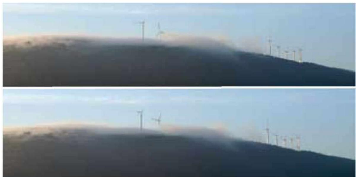
Imágenes tomadas con un intervalo de un par de segundos en la costa de Lugo. Todos los molinos eólicos estaban parados menos el 2º de la izquierda. Detrás de él se observa claramente el efecto de la captación de energía del viento en la disipación de la niebla (el ligero viento era suficiente para ir disipando la niebla en el resto del parque). Foto: AUTOR.
