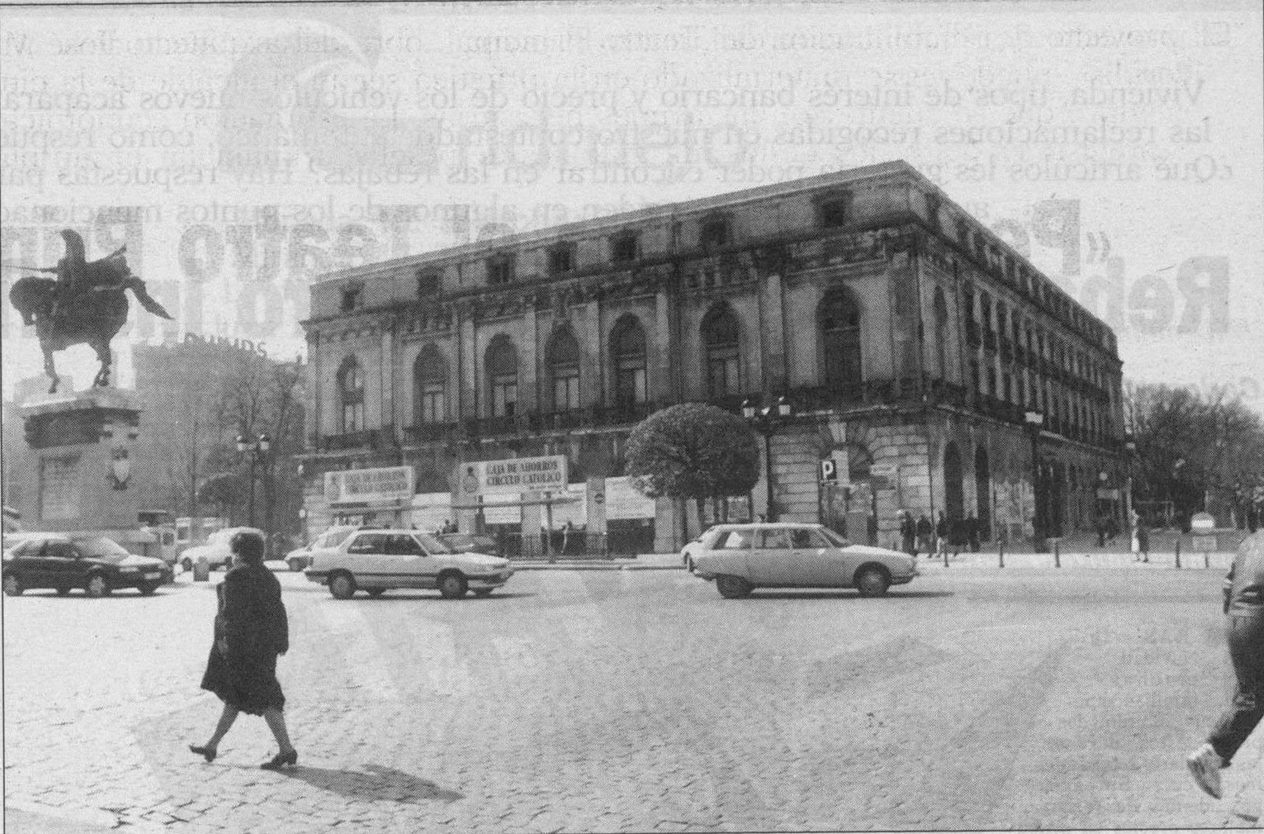
Vista general del antiguo Teatro Principal, cuya entrada, según este proyecto, seguiría estando en plaza de Primo de Rivera. PATRICIA
